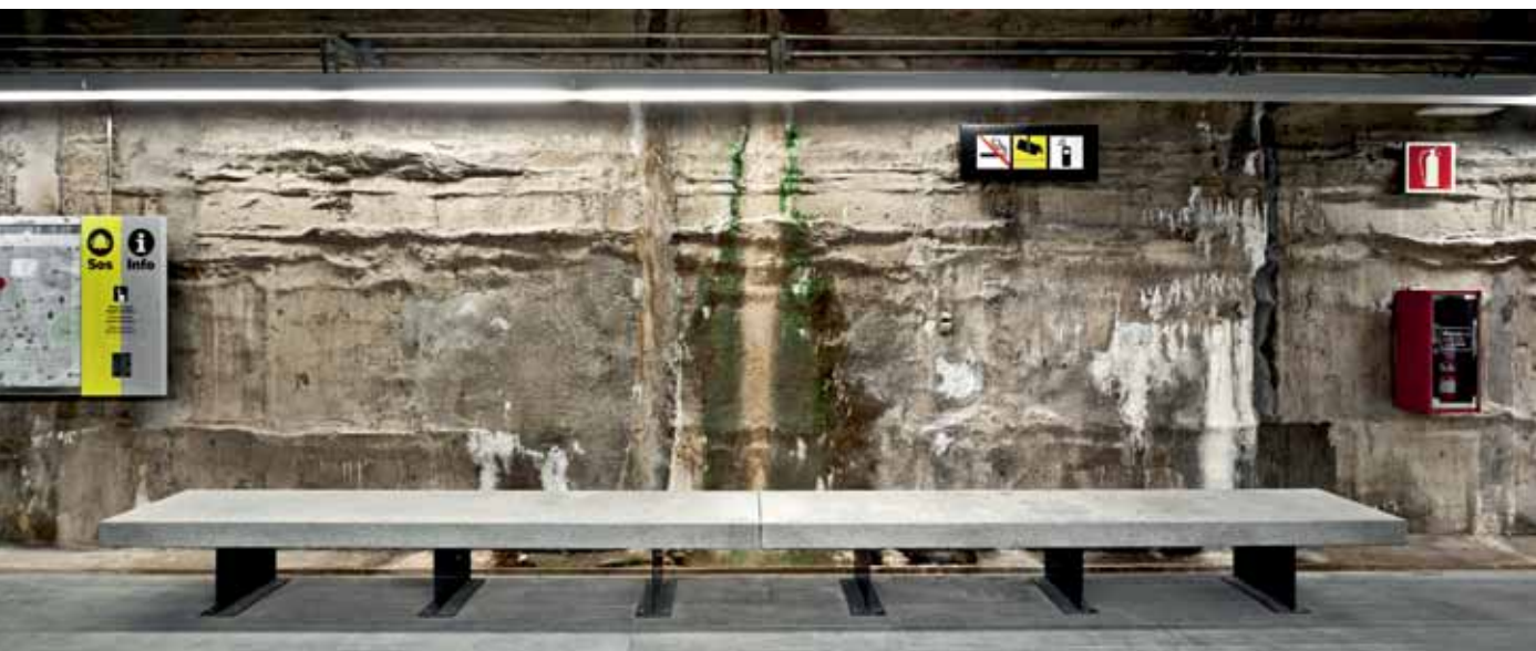
Top: The slurry walls of the Logistic Park station are treated as the final finish. Bottom: the station furniture is minimalist but functional / Arriba: Las paredes sin tratar como acabado final en la estación Logistic Park. Abajo: el mobiliario de la estación es minimalista pero funcional. Photos / Fotos: © Adrià Goula
